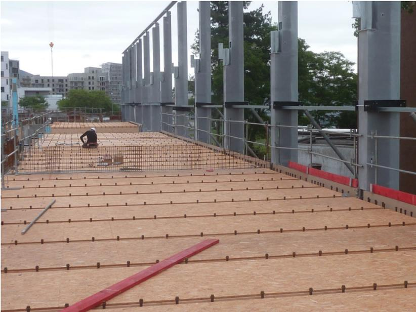
**Plancher mixte bois-béton avec connecteurs acier**
